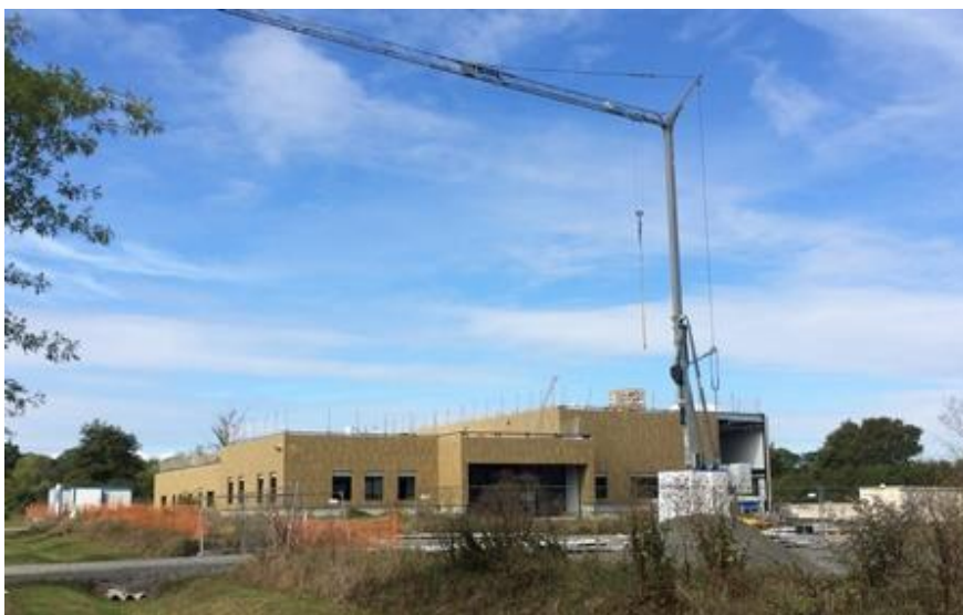
Construction du futur bâtiment de JCE Biotechnology
